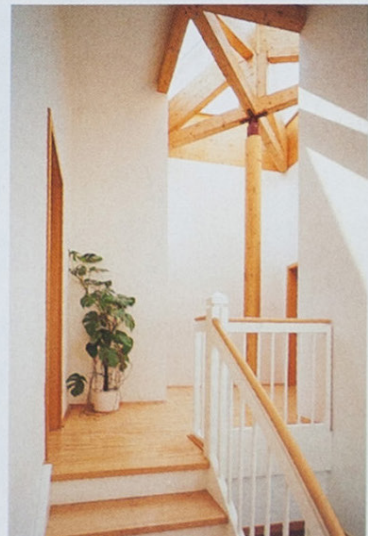
Auf Lüftungskappen wurde verzichtet – zu teuer. Der Minidachstuhl über der Leimbinderstütze fängt Spannungen der Konstruktion auf.
